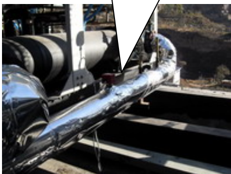
Корректный монтаж реле протока
