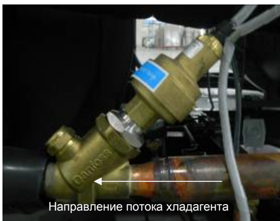
Направление потока хладагента в электронном расширительном вентиле.
