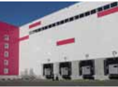
Распределительный центр Wildberries г. о. Подольск, МО
